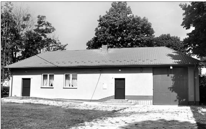
Świetlica wiejska w Natalinie po remoncie
