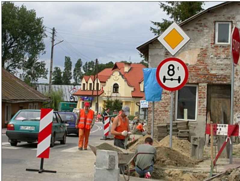
Prace przy modernizacji chodników w okolicy Rynku
