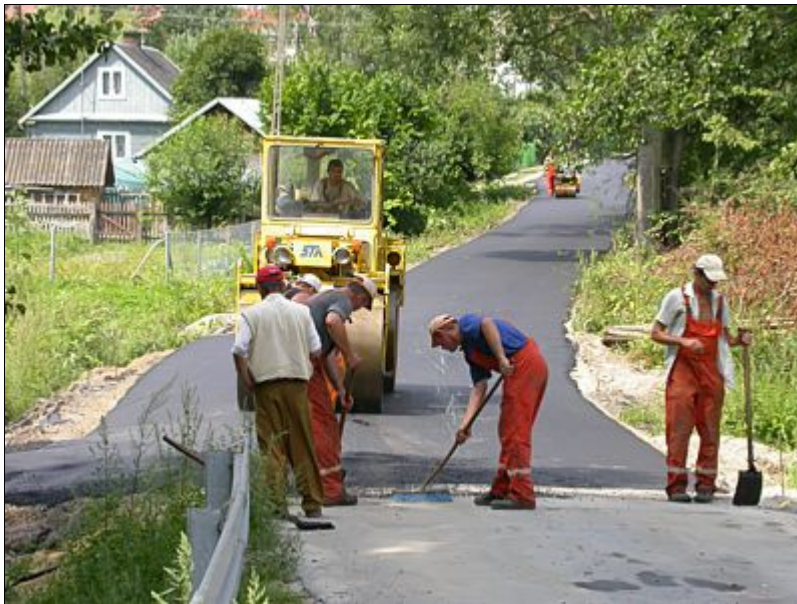
Budowa drogi Osada–Mikuszewskie
