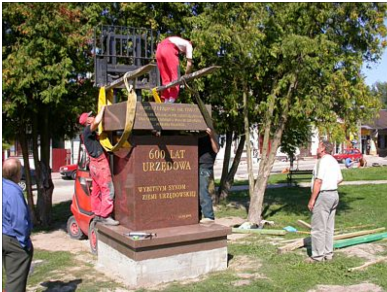
Budowa pomnika 600-lecia Urzędowa
