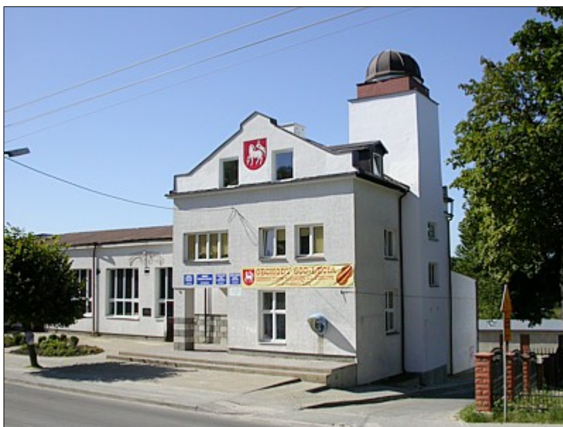
Budynek GOK w Urzędowie z kopułą obserwatorium astronomicznego
